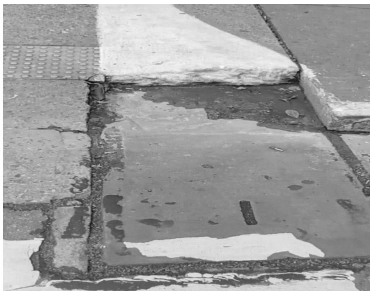
Figura 3 - Desnível da faixa de pedestre para calçada
