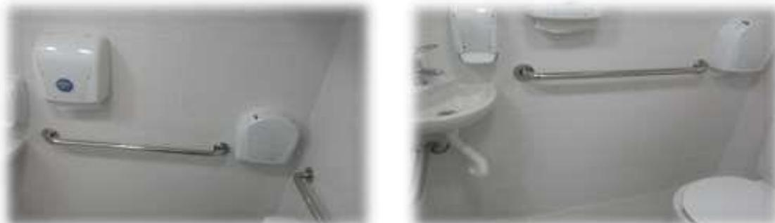
Figura 55: Instalação de barras de apoio nos banheiros para PNE
