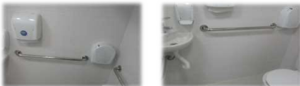
Figura 62: Instalação de barras de apoio nos banheiros para PNE
