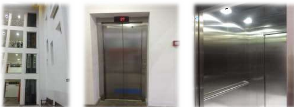
Figura 64: Modernização e Troca da Cabine do Elevador
