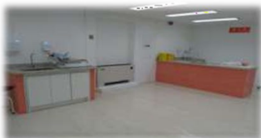
Figura 59: Instalação de pias no laboratório de enfermagem
