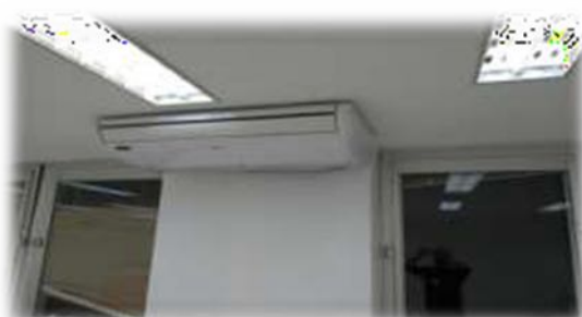
Figura 56: Laboratório de Enfermagem Infantil - Instalação de Ar Condicionado
