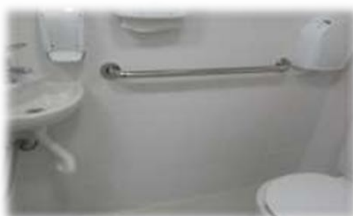
Figura 62: Instalação de barras de apoio nos banheiros para PNE
