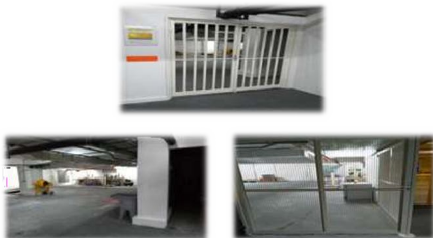
Figura 51: Montagem do Laboratório Canteiro de Obras
