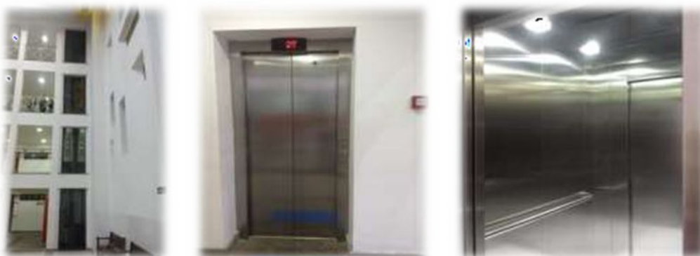
Figura 64: Modernização e Troca da Cabine do Elevador
