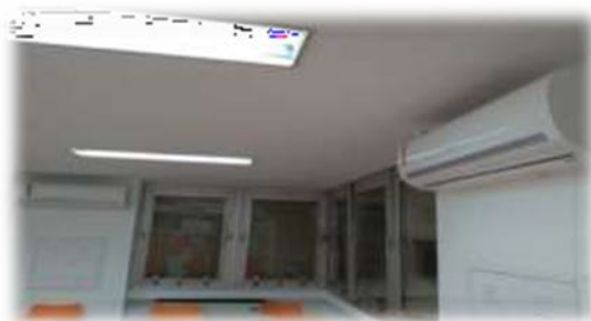
Figura 61: Instalação de Sistema de Ar Condicionado na sala 44
