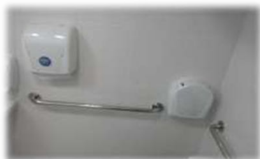
Figura 62: Instalação de barras de apoio nos banheiros para PNE
