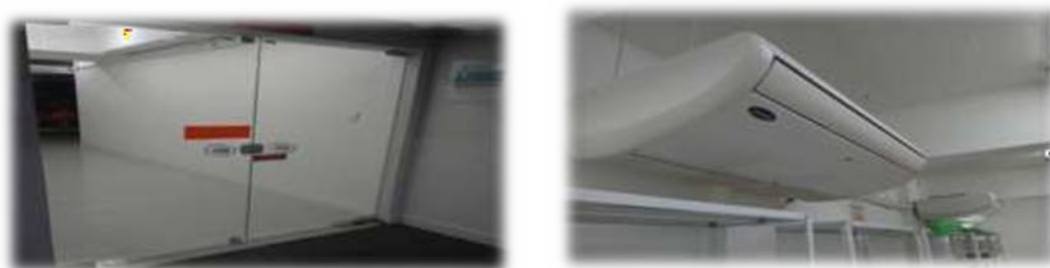
Figura 52: Laboratório de Maquetaria - Instalação de Ar condicionado e Porta de Vidro
