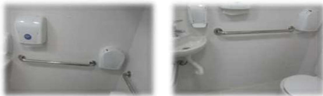
Figura 62: Instalação de barras de apoio nos banheiros para PNE
